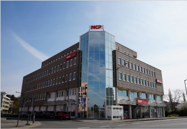
Das Firmengebäude des Nürnberger Unternehmens NCP (Quelle: NCP)
